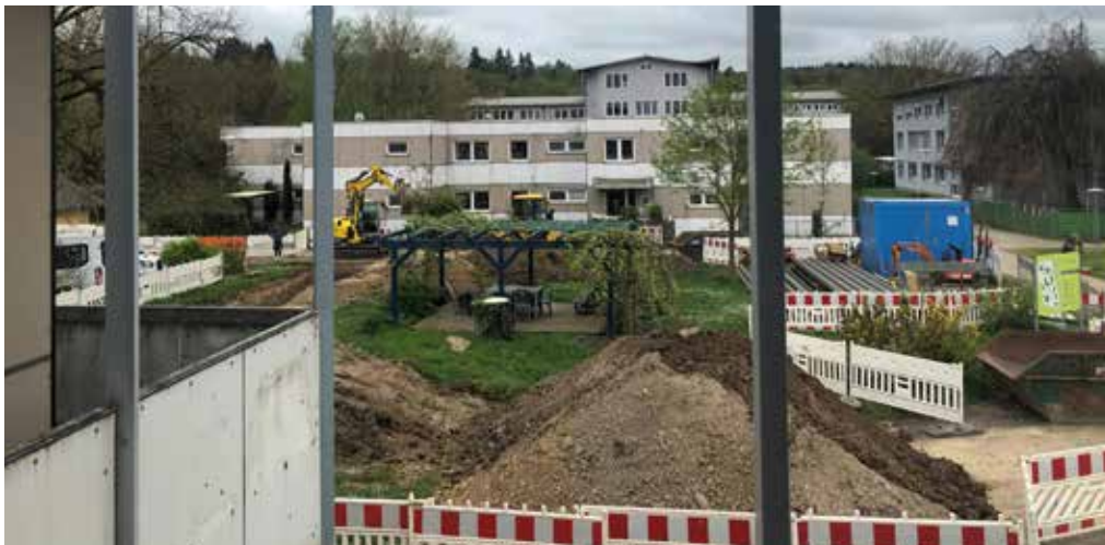
Große Teile des Geländes waren Baustelle
