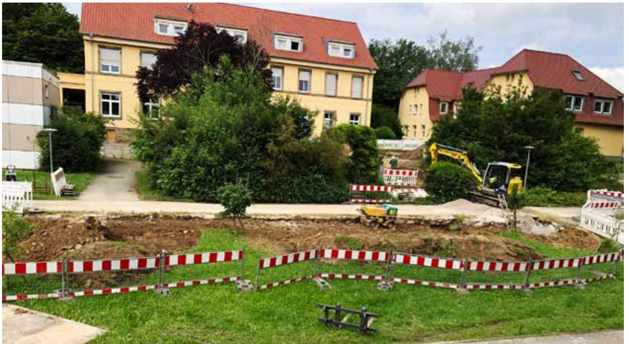
Neue Heizungsrohre und Wasserleitungen wurden verlegt
